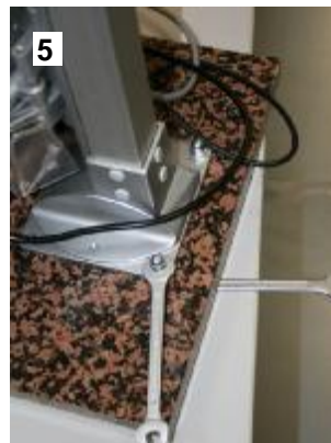
Anschrauben der Muttern auf die Schrauben
